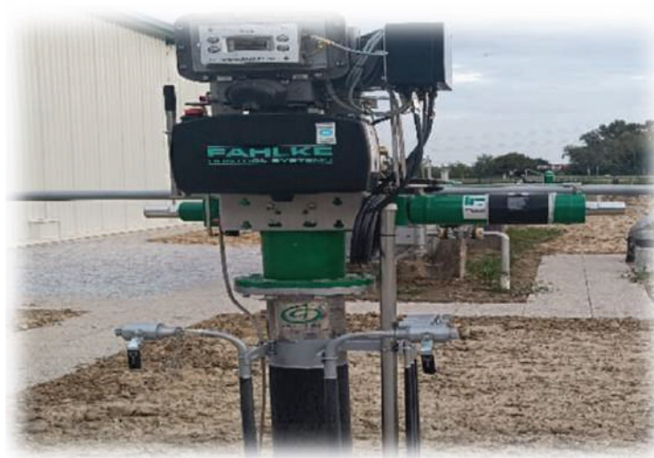
Slika 6. Električni upravljački uređaj Izvor: Plinacro
