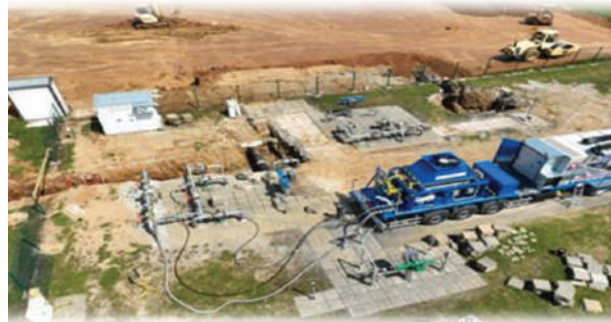
Slika 14. Mobilni kompresor i prepumpavanje plina na PČ Bosiljevo Izvor: Plinacro
