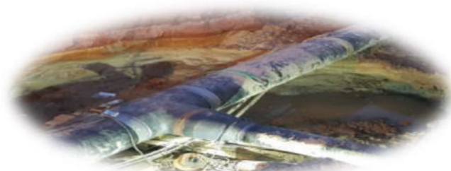
Slika 15. Radovi povezivanja plinovoda DN 600 Zagreb istok – Kutina s PČ Kozarac Izvor: Plinacro
