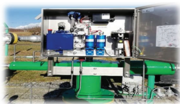
Slika 5. Pneumatski upravljački uređaj Izvor: Plinacro
